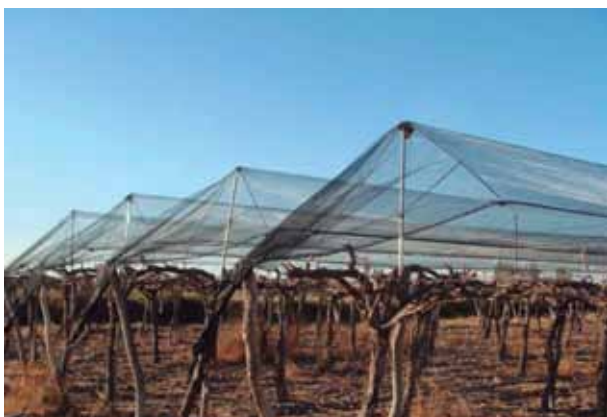
Detalle de la estructura terminada (vista de afuera)
