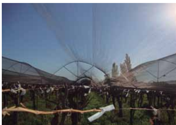
Detalle de la estructura terminada (vista desde el interior)
