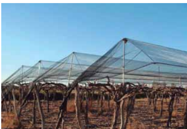
Detalle de la estructura terminada (vista de afuera)
